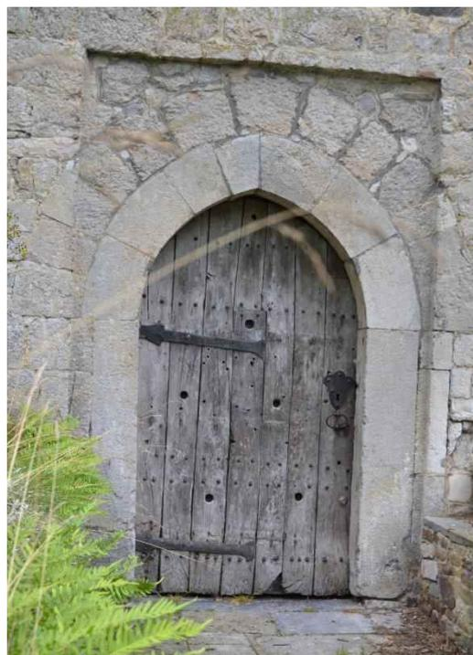
Fig. 2. Feuillure de l'emplacement du pont-levis dans la façade du donjon. © P. ANDRÉ 2016.
