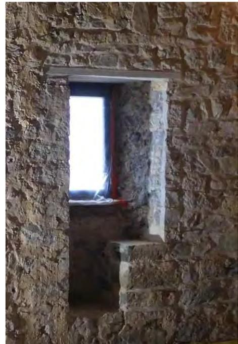
Fig. 8. Baie à banquette simple dégagée dans les moellons en pierre calcaire. © P. ANDRÉ 2019.
